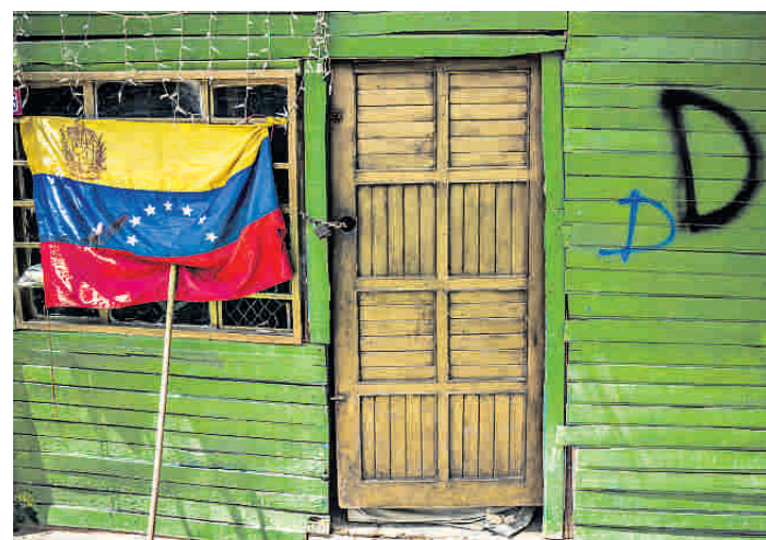
La 'D' atemoriza en la frontera. Es la marca que condena al derrumbe.
